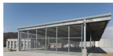
屋根付きパレット保管場
